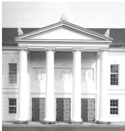
Abb.8 : Portikus Der Wandfries strahlt wieder wie neu, © Klaus Möbus
